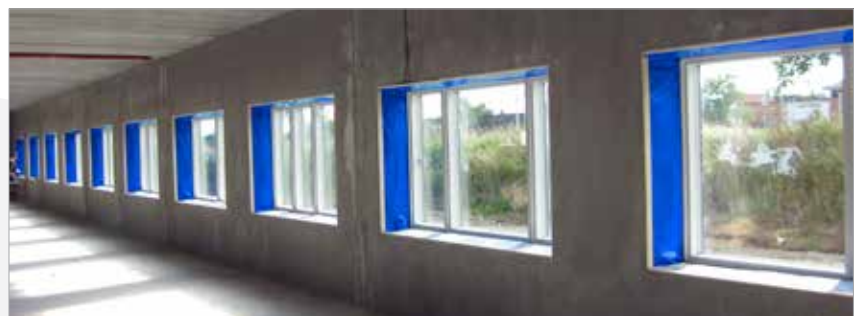
DAFA PE lysningsfolie monteret af PS Lundgaard A/S i NCC's Zenit Company House, Aarhus. Målet er at spare 25 procent på energirammen i nyt erhvervsbyggeri. NCC er den første danske deltager i EU's Green Building-program, der skal skabe vedvarende CO2-reduktion.
