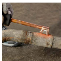
Afmontering af udstødningsrør
