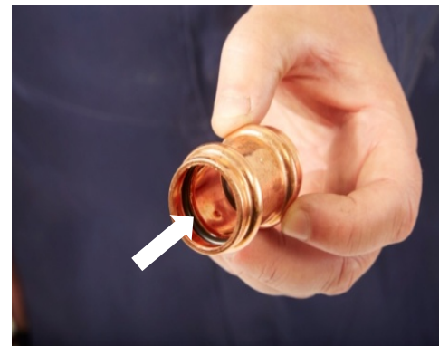
6. Sørg for, at o-ringen sidder korrekt
