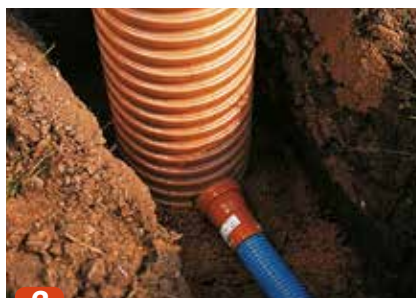
2 Monter drænrøret til dræntilslutningen.
