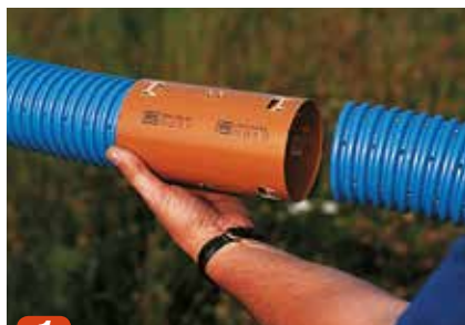
1 Benyt den fabriksmonterede dobbeltmuffe ved samling af rør.
