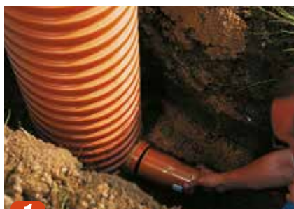
1 Monter dræntilslutning i sandfangsbrønden.
