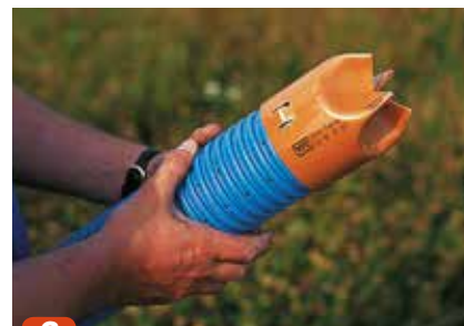
3 Monter også slutmuffen ved at skubbe røret helt i bund.
