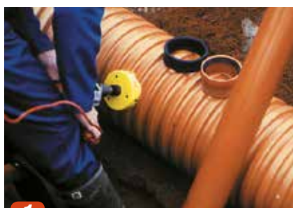
1 Bor hul i opføringsrøret med en 127 mm hulsav.
