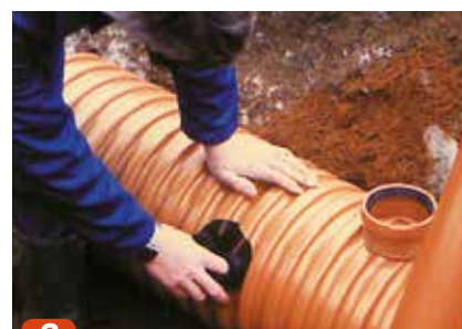
3 Tryk Wafix muffen på plads og monter dræntilslutningen.
