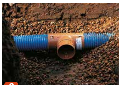
2 Fjern det afskårne stykke rør og sæt sadlen på.
