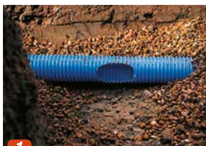
1 Frigrav det eksisterende drænrør og skær hul med en kniv.
