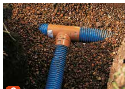
3 Monter afgreningen ved at skyde røret helt i bund i sadelgrenrørets muffe.
