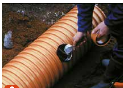
2 Monter gummiringen og smør med glidemiddel.
