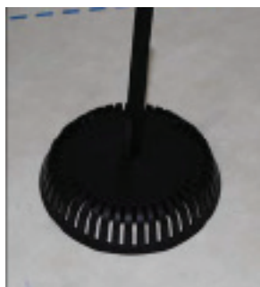
Undertagsventilen er nu monteret.
