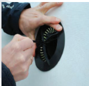
Dæksel trækkes stramt ned til undertaget indefra.
